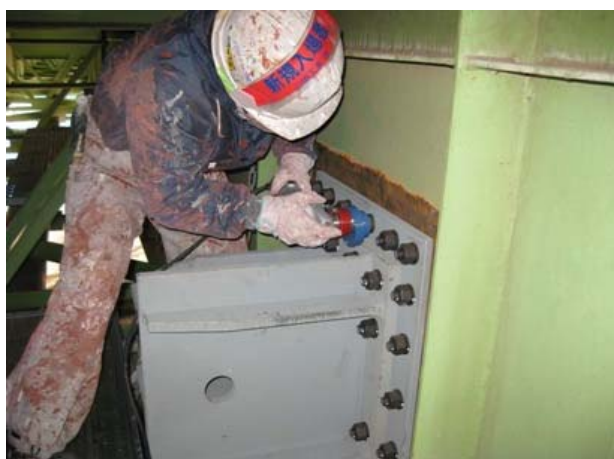
大渡橋補修工事におけるE Zクリーナー使用状況
