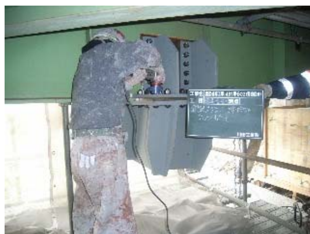
大渡橋補修工事におけるE Zクリーナー使用状況
