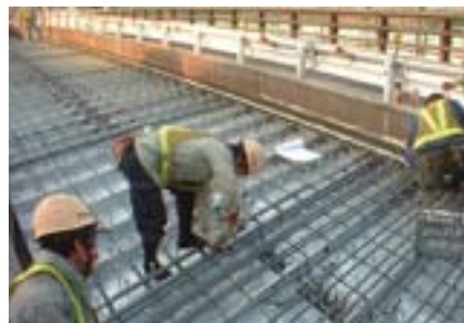
場所打ちタイプによる床版取替え
