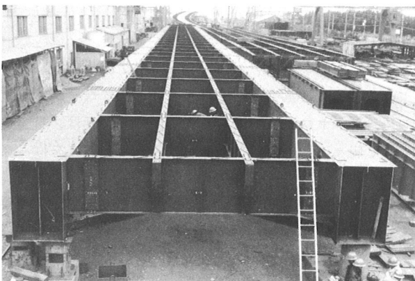
写真-2 補剛桁の組立
