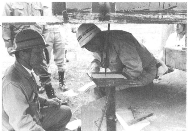
写真-4 温度による軌跡調査(拱弦材)
