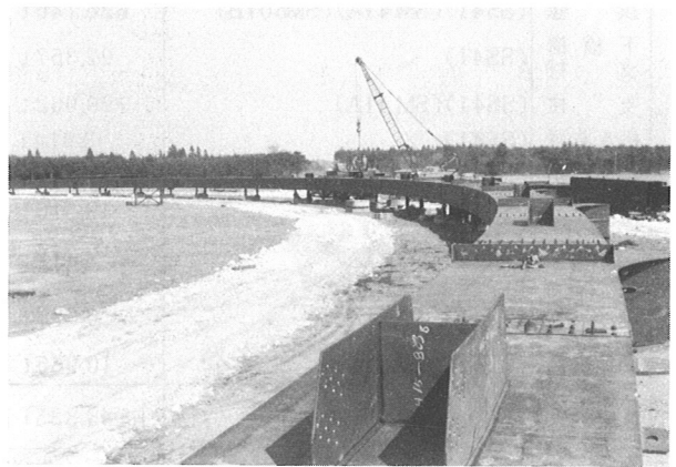
写真-3 拱弦材の平面組立
