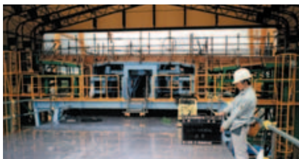
セグメント製作台
