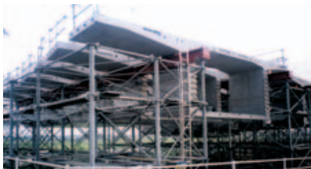
セグメント仮置き状況
