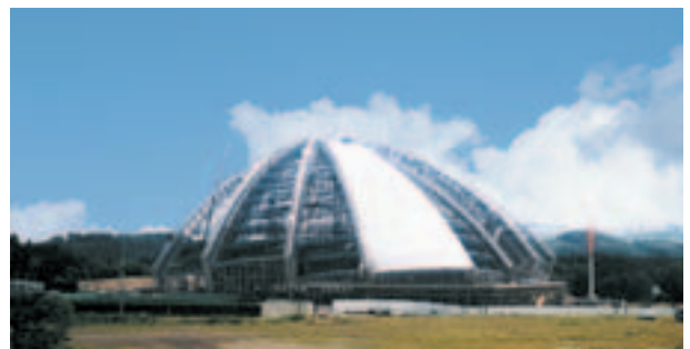
仙台ドーム全景（建設中）
