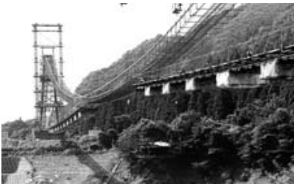
写真5 橋体の架設
