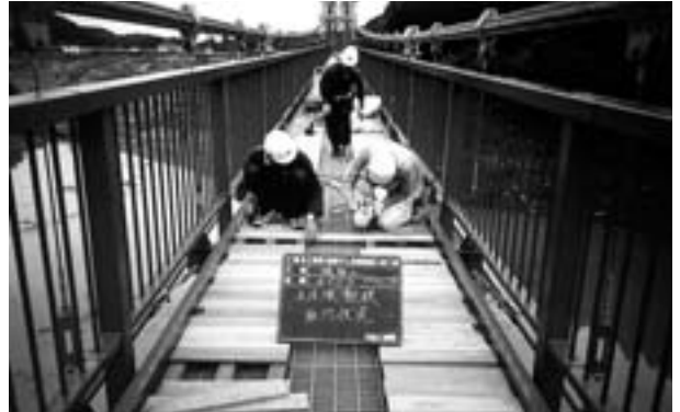
写真7 床組の架設
