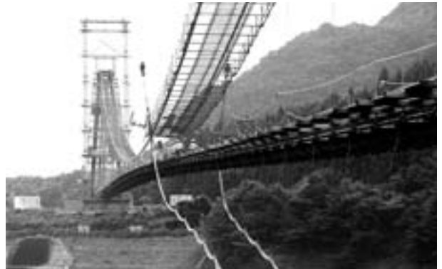
写真6 耐風索の架設
