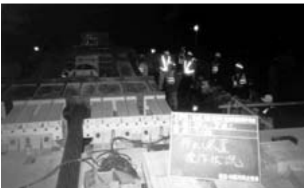
写真5 押し出し装置操作状況
