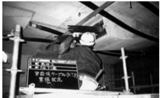
写真1 仮設PC鋼材緊張状況
