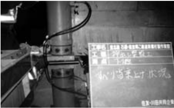
写真3 P25支点への乗り上げ状況
