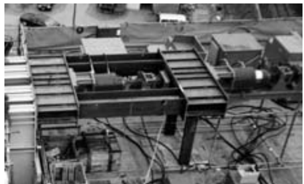
写真2 押し出しジャッキ、ポンプ
