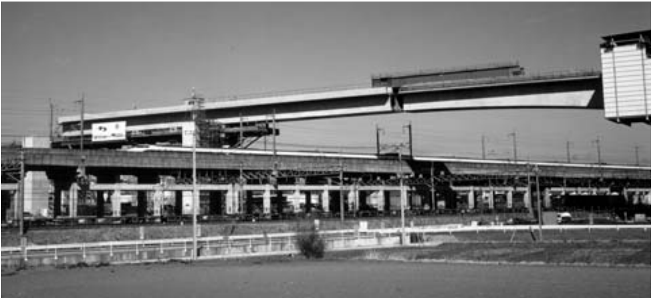
写真7 押し出し作業完了
