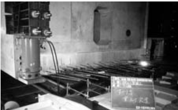
写真4 主桁誘導装置
