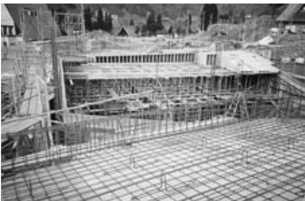
写真3 スラブ型枠の建込み
