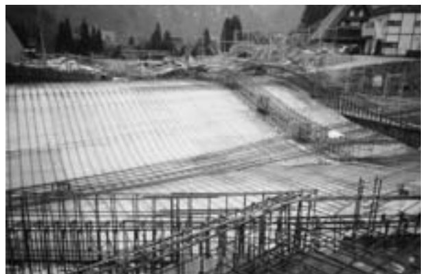
写真4 スラブ下筋の組立て
