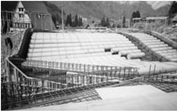
写真5 ポイドの取付け
