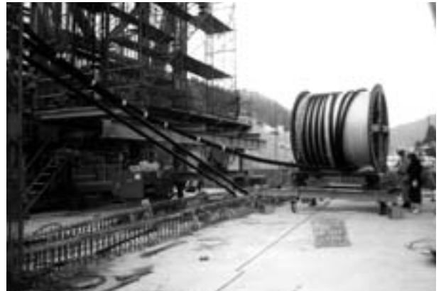
写真3 斜材架設状況(その2)
