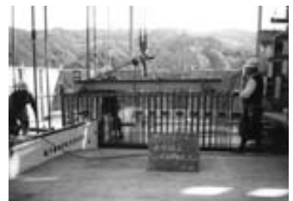
写真6 プレハブ鉄筋据付状況
