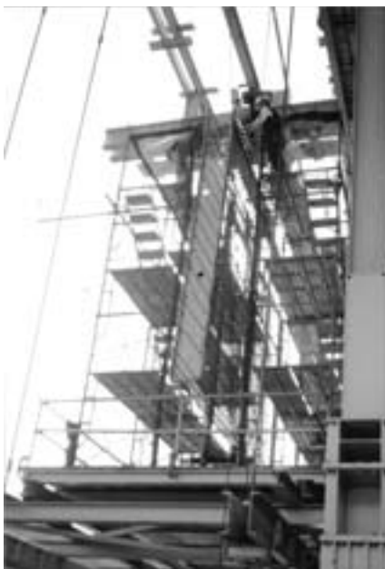
写真5 ウェブ鉄筋先組状況
