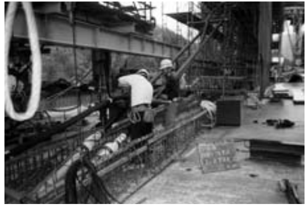
写真2 斜材架設状況(その1)
