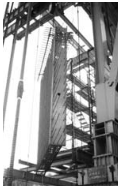
写真6 プレハブ鉄筋据付状況
