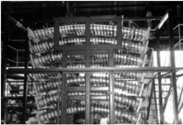
写真1 サドル組立状況
