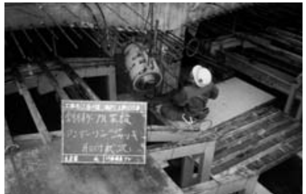
写真4 斜材緊張状況
