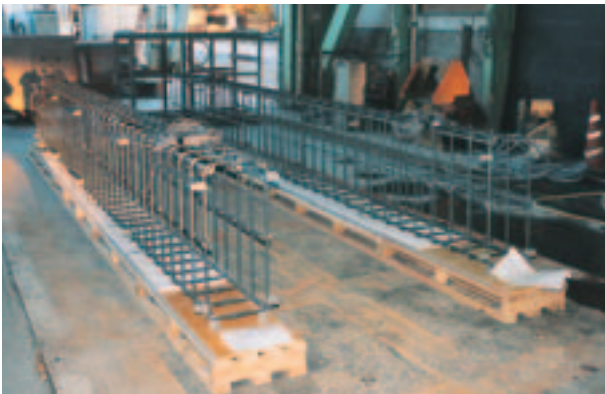
写真1 試験体製作状況
