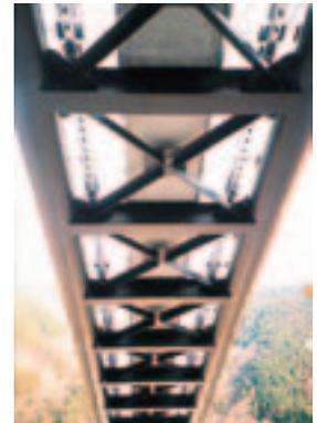
補剛桁に鋼管を採用
