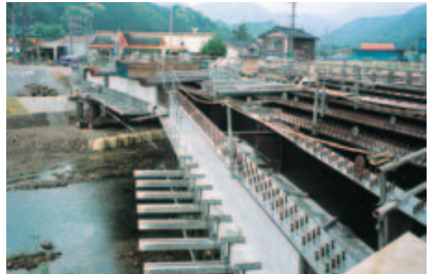
外げた外側（コンクリートウェブ構造）
