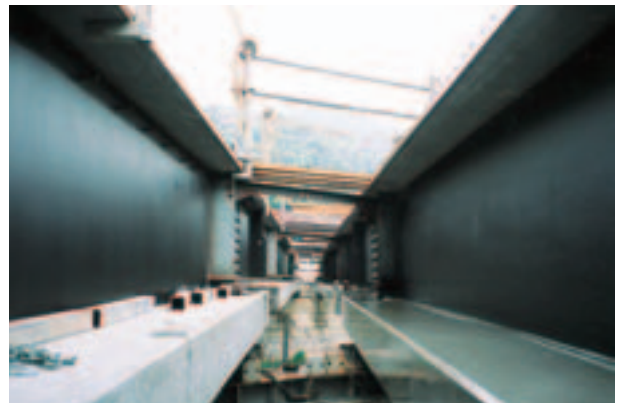
中げた（鋼板ウェブ構造）
