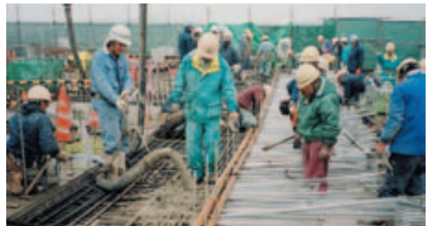
現場打設状況
