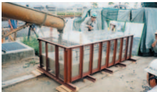
実物大アクリル板模型打設施工試験
