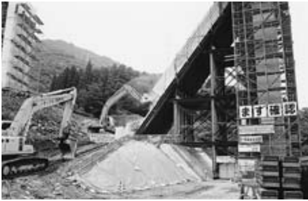
写真5 バックステイの解体
