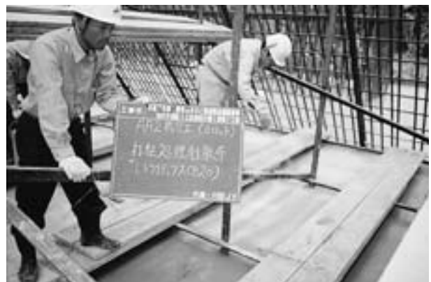
写真2 トライテックス散布状況
