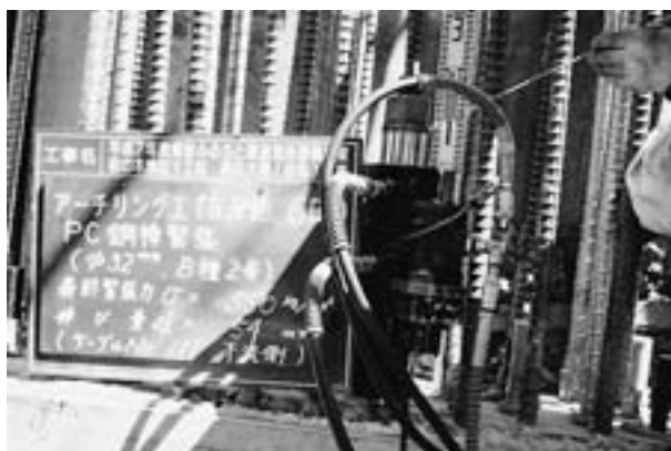
写真4 電動FABジャッキ
