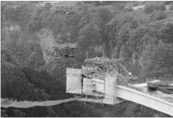
写真6 メラン鋼材の閉合
