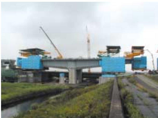
写真1 鍋田西高架橋施工状況
