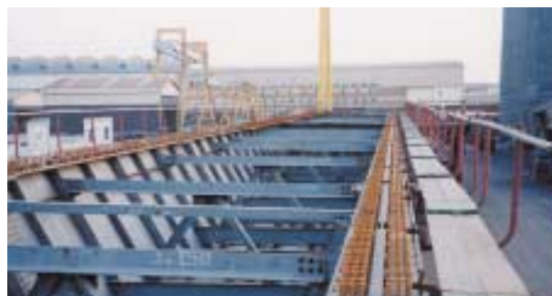
工場仮組時の開断面箱桁
