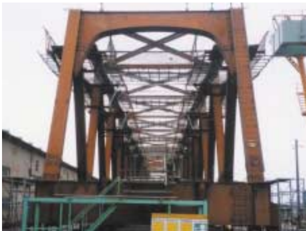
写真1 小貝川橋梁断面（仮組時）
