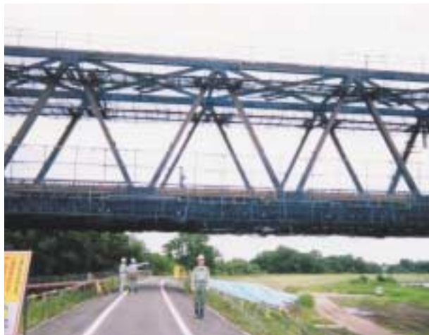
写真2 P8 - P9径間架設時
