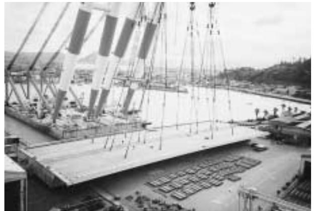
写真1 鋼桁の浜出し状況
