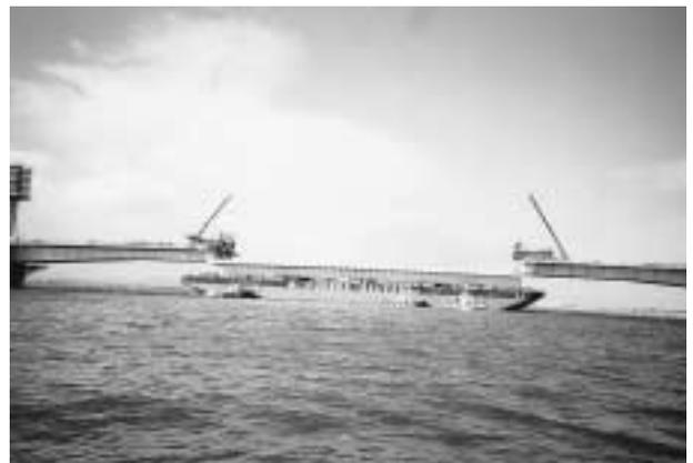
写真2 鋼桁大ブロック架設状況
