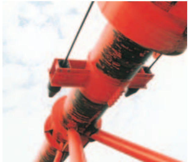
上弦材への連結ケーブルの設置
