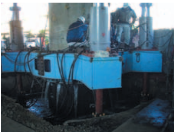
図4 補強鋼板圧入状況
