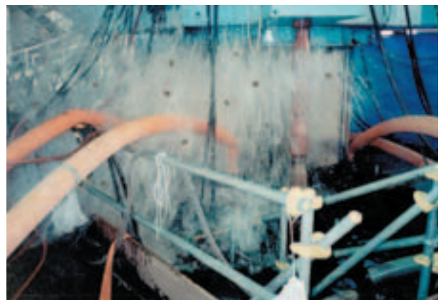
図6 壁式エアリフトによる礫処理状況
