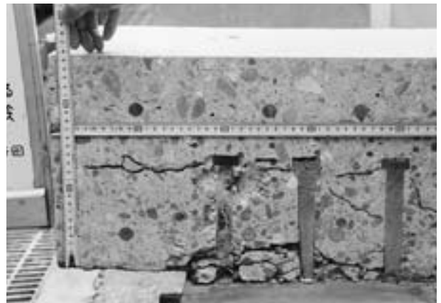
写真5 疲労破壊状況 (例: S-5-1)
