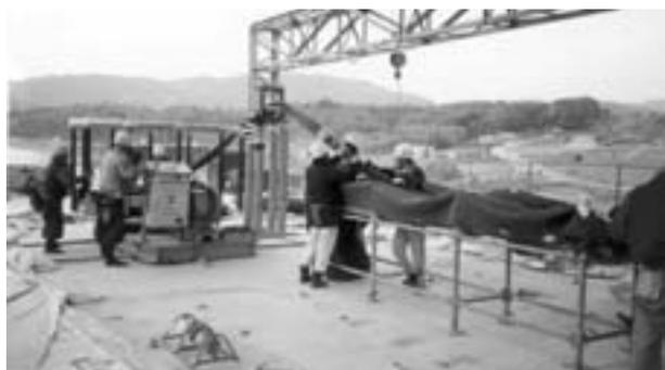
写真4 ターンローラーによる展開挿入
