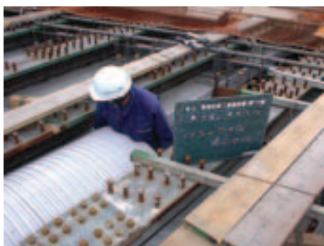
アーチフォーム敷設状況
