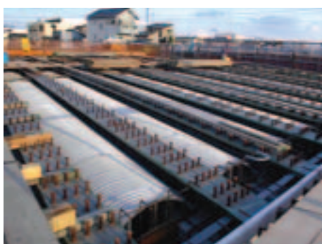
アーチフォーム敷設完了（上面）
