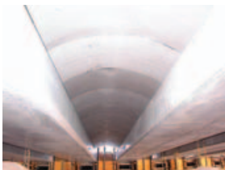
アーチフォーム敷設完了（下面）
