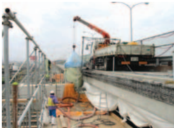
ウォータージェット工法 施工状況
