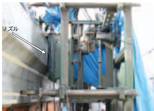
ウォータージェット工法 はつり装置（ノズル先端部）
