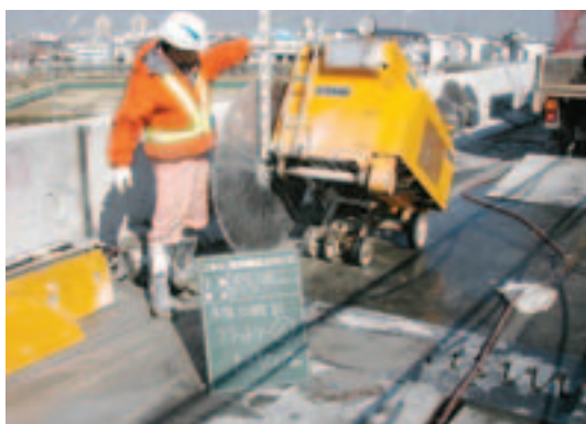
フラットソーによる床版切断（橋軸方向）
