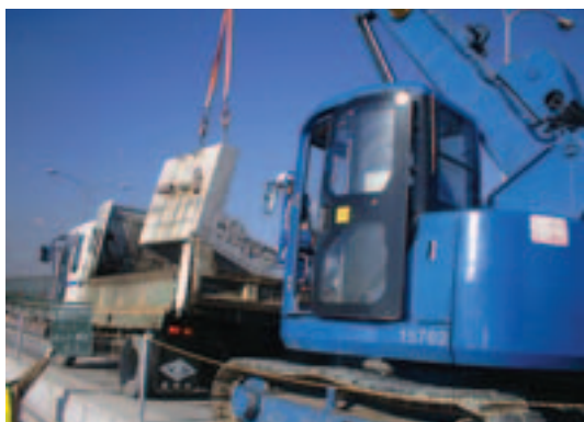
切断ブロック撤去・搬出
