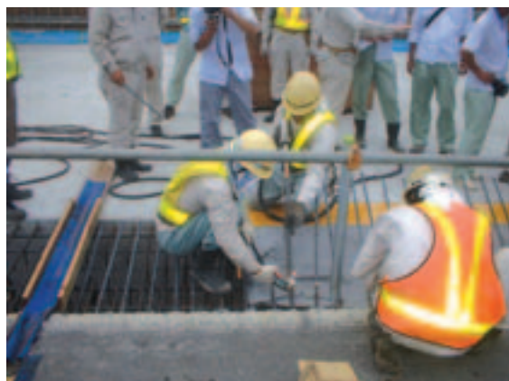
スカッドロック工法 施工状況
