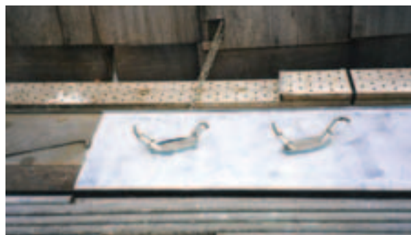
樹脂モルタルの施工状況
