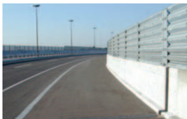
千歳高架橋D橋RIGHT橋
