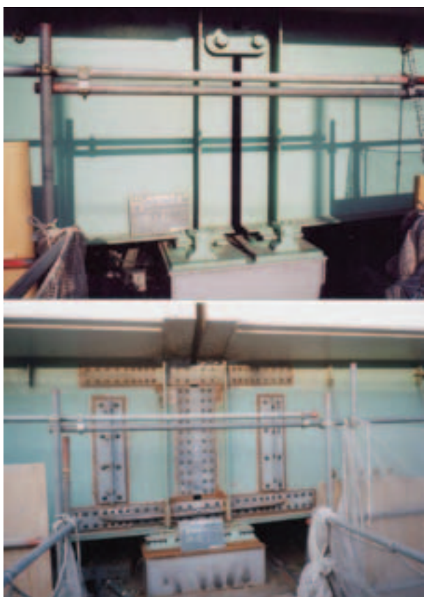
連結部施工前(上)と施工後(下)
