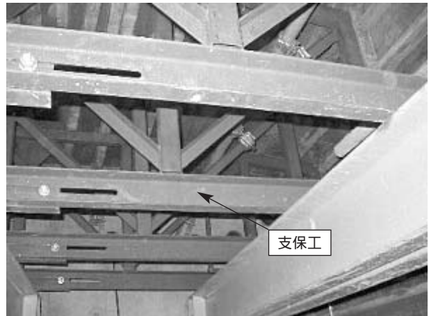
写真4 リブ背面の支保工
