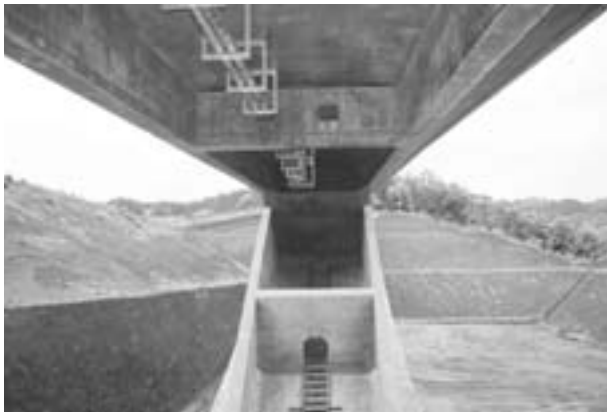
写真3 アーチ分岐部
