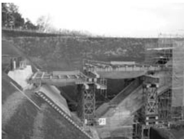
写真7 側径間部支保工
