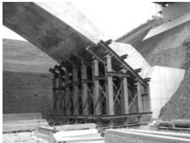
写真5 スプリング部支保工
