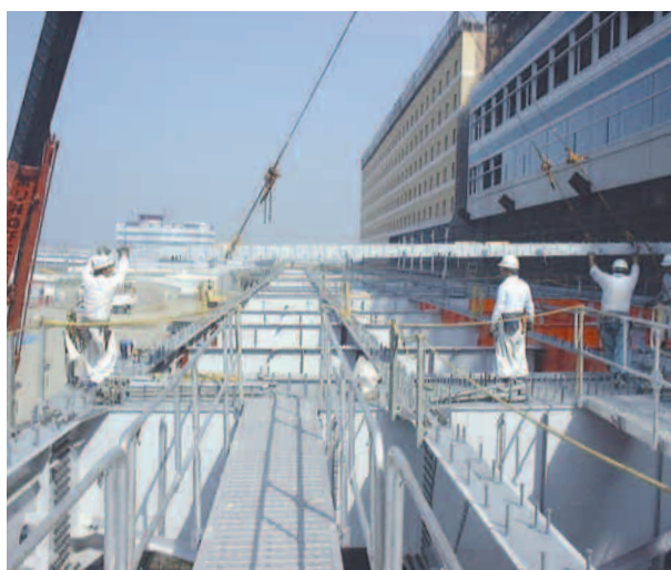
合成床版（SCデッキパネル）設置状況
