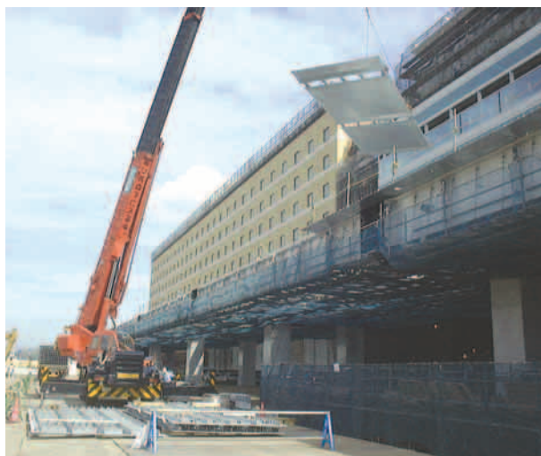
合成床版（SCデッキパネル）架設状況
