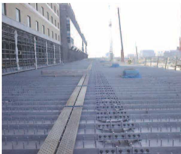
合成床版（SCデッキパネル）設置完了
