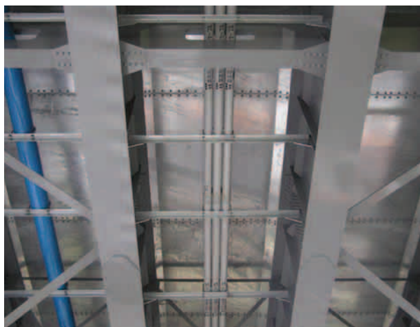
写真1 SCデッキ下面
