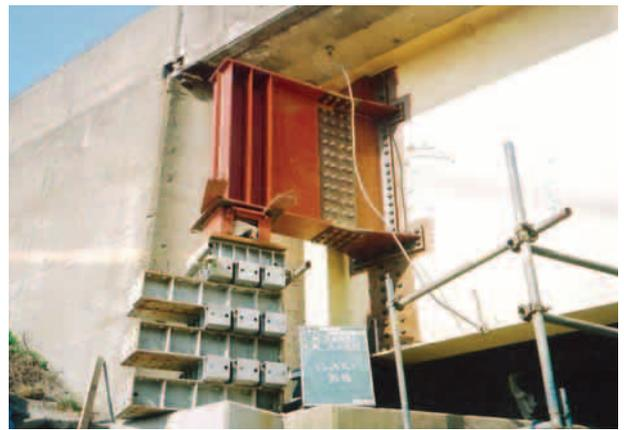
主桁付きブラケット工法（端部）
