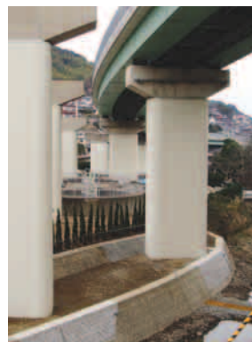
施工完了全景
