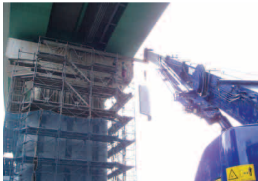
プレキャストパネル架設状況
