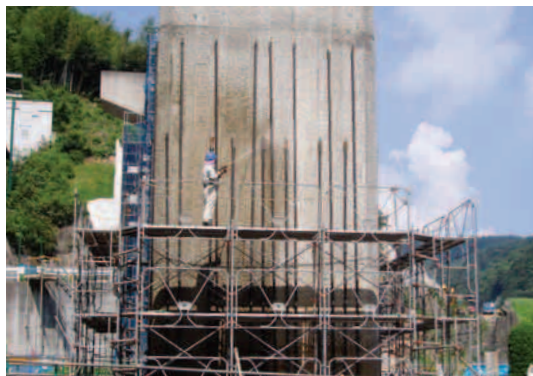
補強鉄筋建込み
