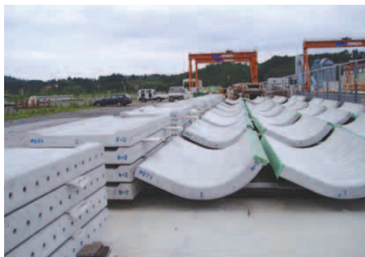
パネル仮置き状況
