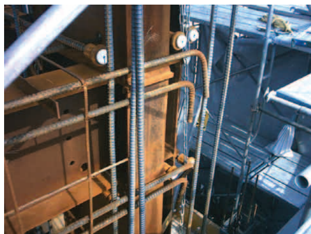
配筋終了状況
