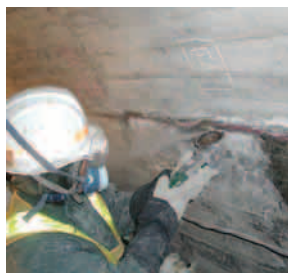
ひび割れ止水工（溝切り状況）
