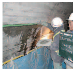
ひび割れ止水工（シール工）
