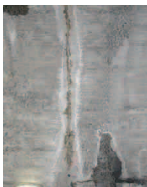
線導水工（施工前2）
