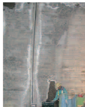
線導水工（施工後2）
