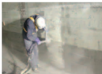
素地調整工（ブラスト状況）
