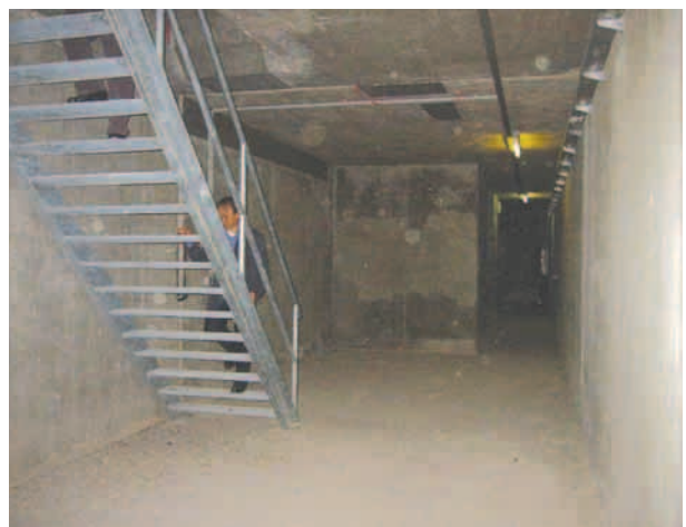
写真1 点検が容易なPC橋の橋台の中 橋脚上も同様に点検しやすくなっていた
