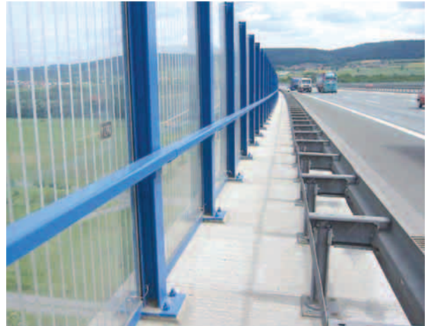
写真2 鋼製ガードレールと壁高欄、防音壁の間の通路 路側から点検が可能
