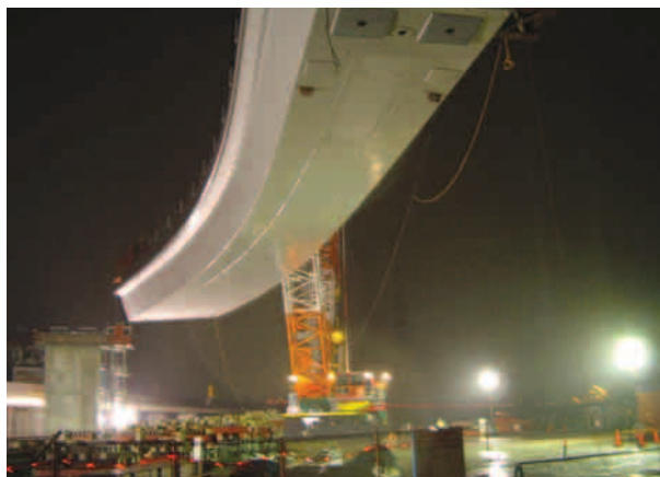
写真4 大ブロック架設
