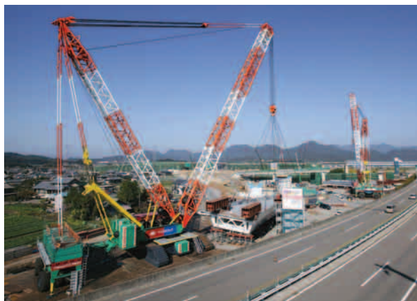
写真3 1 250 t吊クレーン
