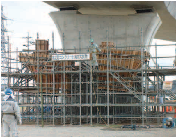
写真6 高流動コンクリート実物大試験体
