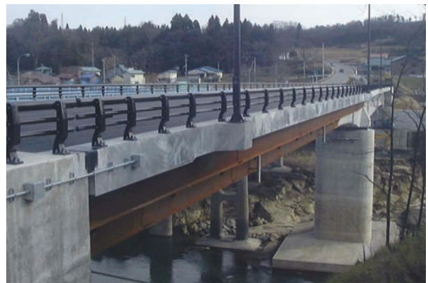
完成写真（起点側から望む）
