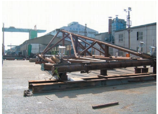
工場ヤードでの仮組立状況
