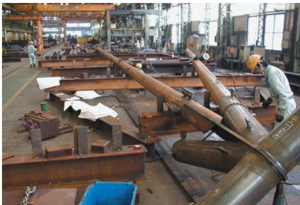
トラス部材の面組立作業
