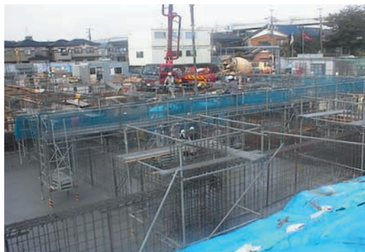
写真1 通例の基礎工事状況
