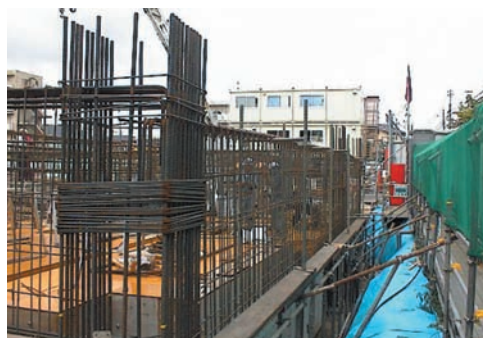
写真3 基礎梁配筋
