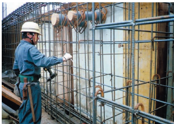
写真7 落とし込み後施工状況（外部側）
