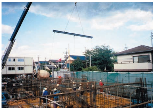
写真6 基礎梁組立鉄筋落とし込み状況
