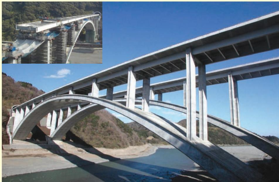
特色：本橋は、一級河川富士川河口より約7 km上流に架かる橋梁である。形式は、高速道路の路面を支える補剛桁を鋼2主桁形式、アーチ本体を鉄筋コンクリート固定アーチ形式とした我が国初の鋼・コンクリート複合アーチであり、そのスパン265.0 mは日本最大である。補剛桁は、隣接するトンネル内において全断面現場溶接継手により連結し、送り出し工法で架設した。（2004年土木学会田中賞受賞）
