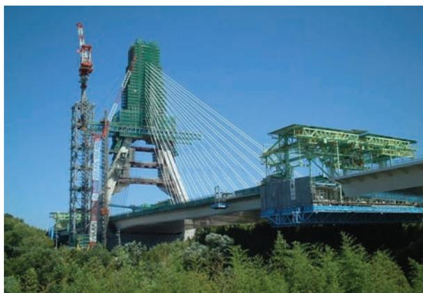
写真7 張出し架設完了
