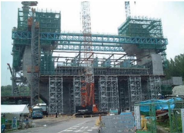
写真3 主塔分岐部および主桁柱頭部の施工
