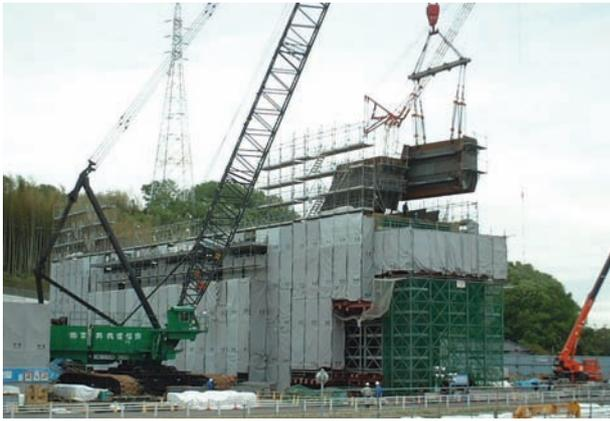
写真2 主塔鋼殻の施工状況
