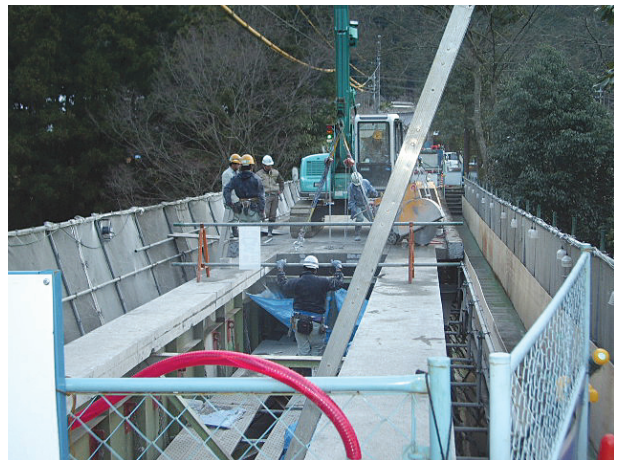
写真1 床版撤去状況
