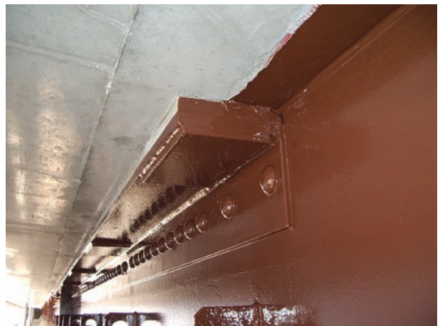
写真3 上フランジ補強板
