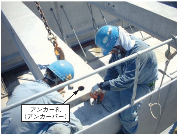
写真6 屋根梁の架設
