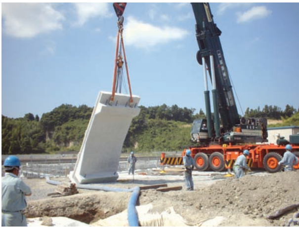
写真3 側面壁の建て起こし
