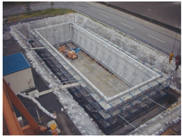
写真5 側面壁の設置完了
