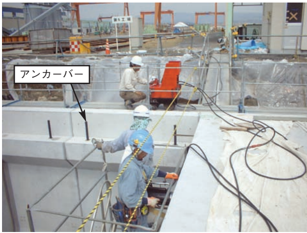
写真7 横締PC鋼材の緊張
