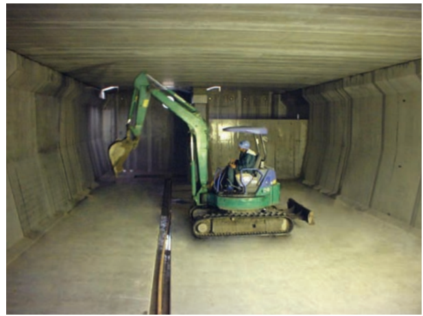
写真9 完成した貯水槽の内部
