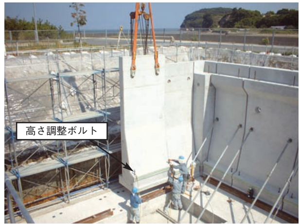
写真4 側面壁の設置
