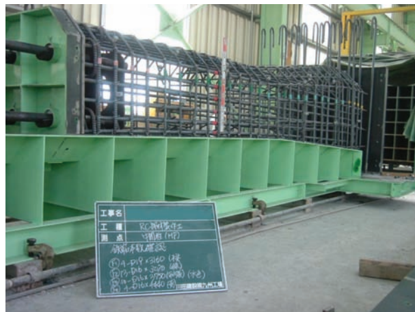
写真1 中間柱 (RC部材) の製作
