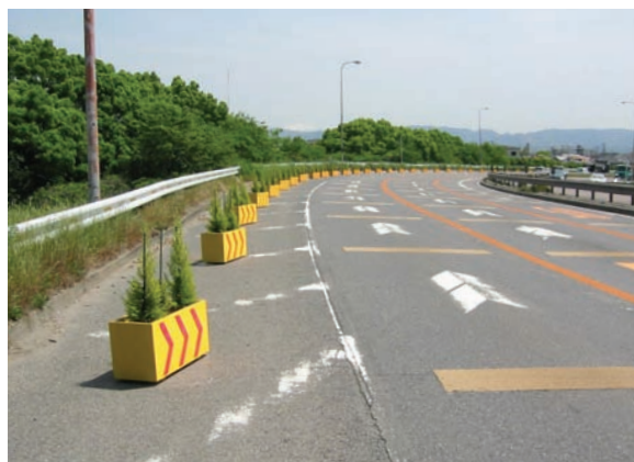
写真7 視線誘導板付プランター
