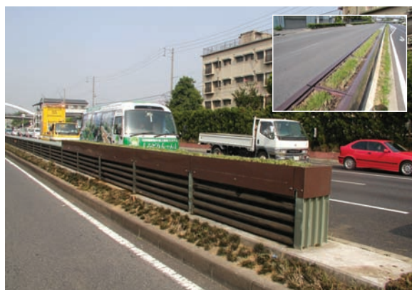
写真6 遮音壁上緑化システム工
