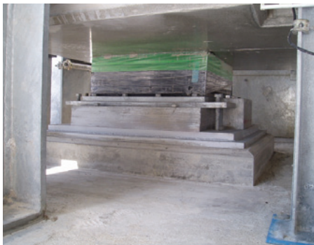
写真1 上部モルタル施工状況
