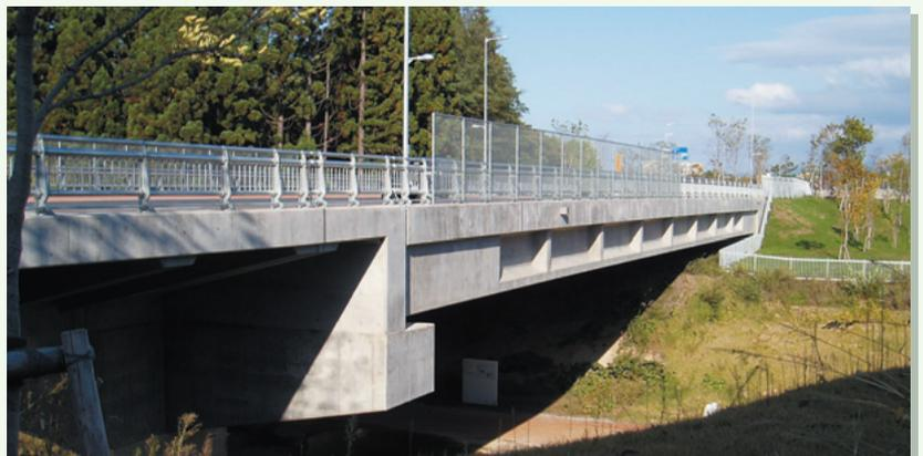
架設桁上で桁の組立を行い、550 t および400 t 吊りトラッククレーンで相吊り架設を行った。（本文p.74参照）
