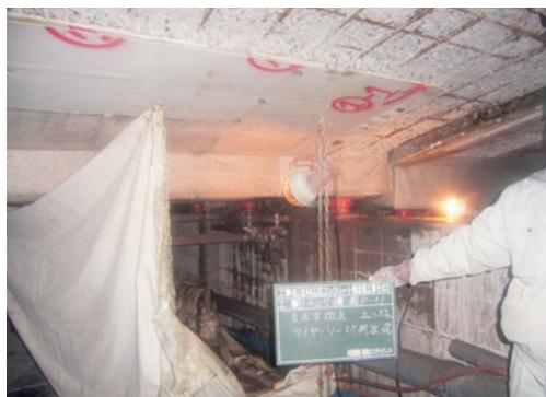
写真11 沓座コンクリート撤去 (ワイヤーソー切断)
