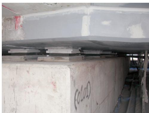
写真12 床版連結部支承取替完了
