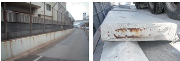
写真6 壁高欄鉄筋腐食によるひび割れ
