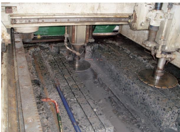
写真19 水平カッター切断状況
