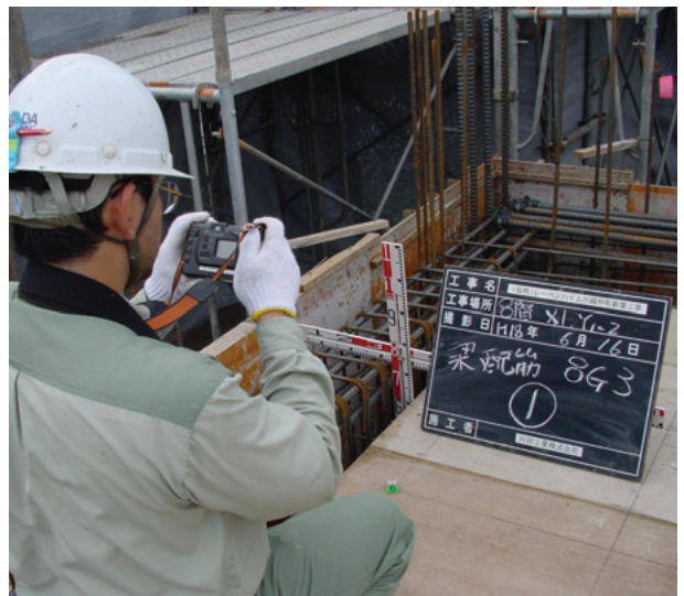
写真2 検査箇所の撮影
