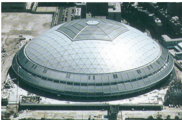
ナゴヤドーム (1997年竣工)
