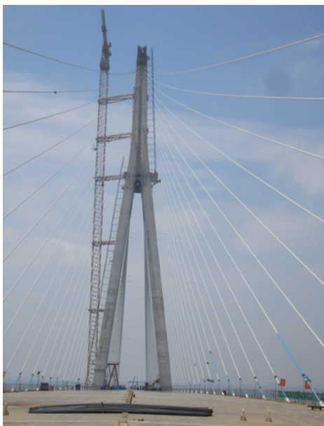
ケーブル架設完了状況
