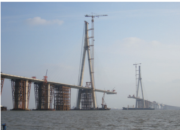
施工中の蘇通大橋全景（2007年3月撮影）
