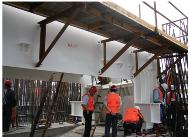
メタルセル据付作業
