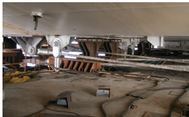
主桁臨時固定設備（水平・鉛直ケーブル、鉛直架台）
