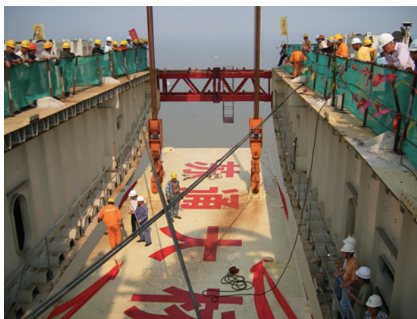
閉合部材架設作業
